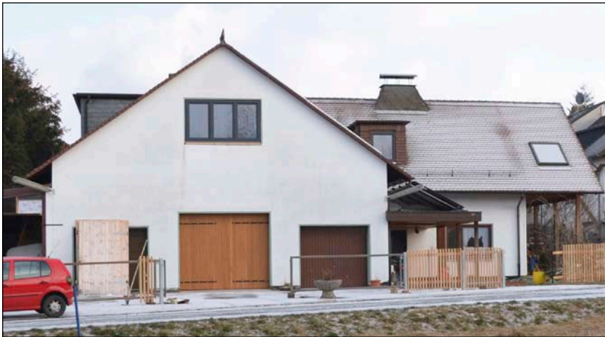
Bild 1: Hausansicht von Westen
