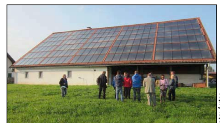
Bild 2: 320 m 2 solarthermische Kollektoren auf dem FHW Urbersdorf
