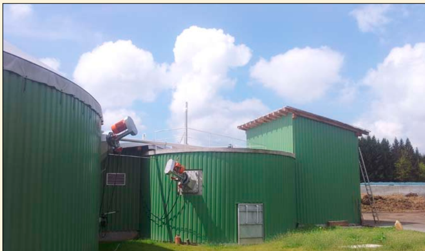
Bild 1: Hydrolysetanks ermöglichen die Vergärung faseriger Einsatzstoffe.
