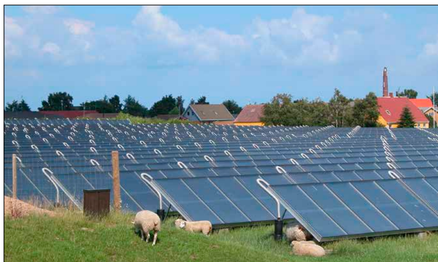
Bild 5: Solarthermie als Freifläche: Erneuerbare Energien im Verbund bei der Marstal Fernwärme auf der dänischen Insel Aerö. Die Kollektorfläche von 33.400 m 2 entspricht einer Nennleistung von 23,4 MW th .
