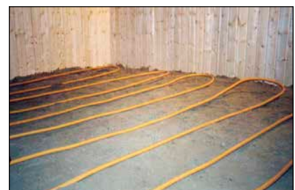
Bild 6: In dieser Abbildung kann man im Hintergrund Holzwände sehen, die vor der eigentlichen Kellerwand mit Abstand montiert wurden. In der Lücke (Holzwand-Kellerwand) befindet sich Isoliermaterial (Glaswolle). Auf dem Boden befindet sich schon eine Schicht Erdmaterial, auf der mäandrierend Kupferrohr verlegt wurde.
