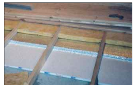
Bild 7: In dieser Abbildung ist der Aufbau der Grundfläche (auf dem das Erdmaterial ruht) zu sehen. Diese besteht (von unten nach oben) aus Betonfußboden, Styropor, Vakuum-Isolierung, Glaswolle und dann Holz.
