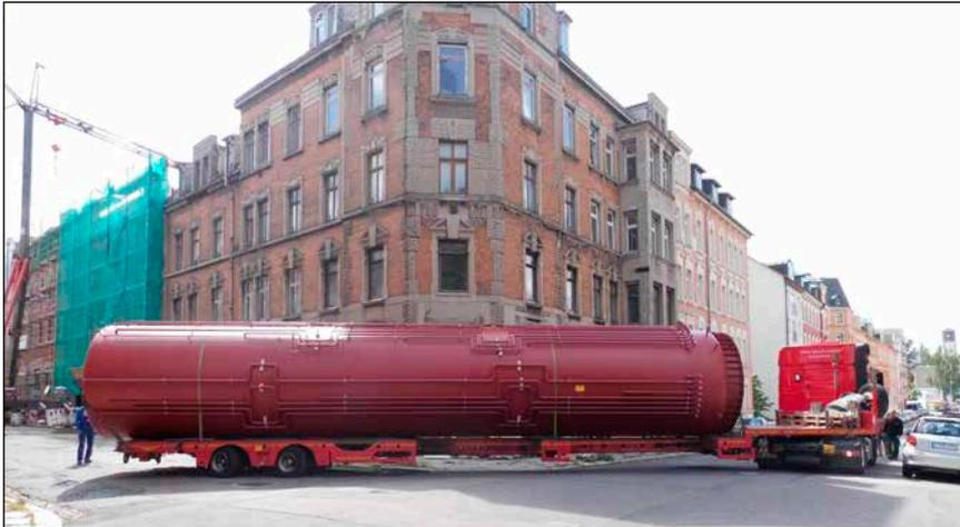
Bild 1: Altbausolarisierung: Statt graue Energie aufzuwenden, Sonnenenergie einlagern. Speicheranlieferung eines knapp 100 m<sup>3</sup> großen Solartanks
