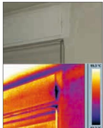
Bild 2: Schwachstelle Rollladenkasten
