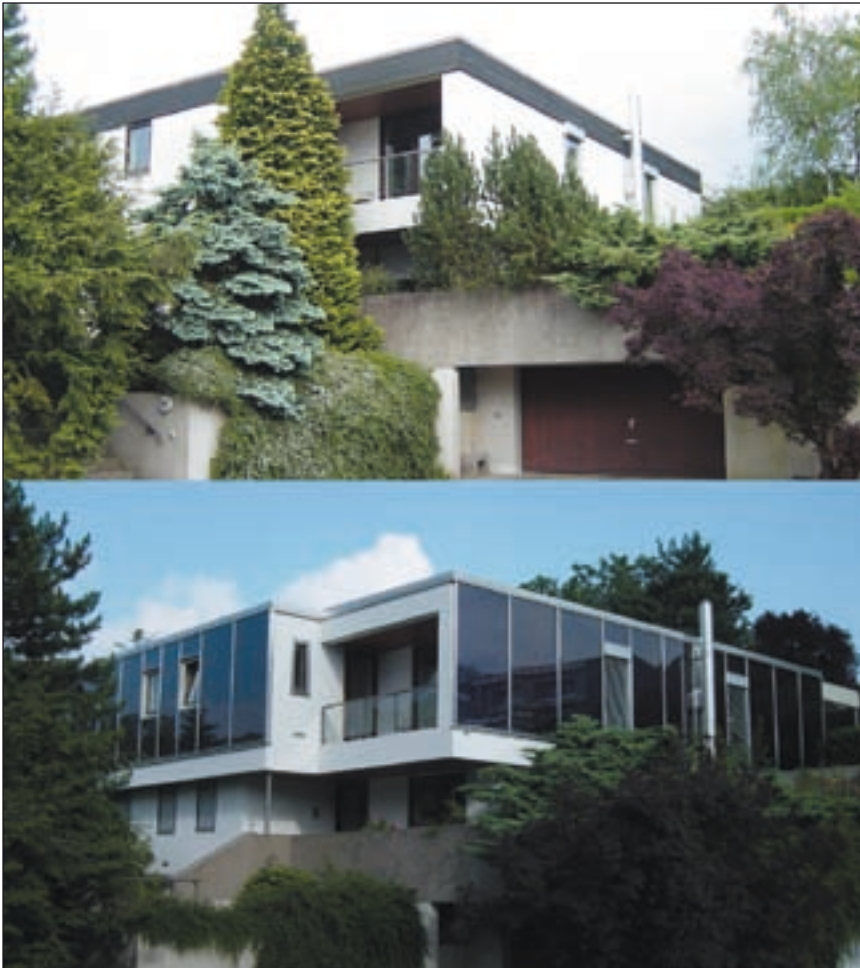
Wohnhaus von 1969 vor und nach dem „solar-aktiven“ Umbau
