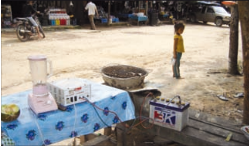
Abb. 6: Energieversorgung über solargeladene Batterien – Problemfall Energieeffizienz
