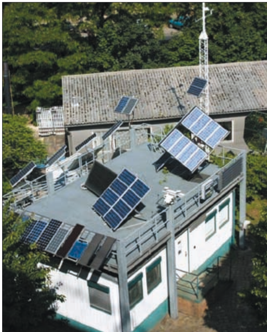
Bild 1: Blick auf das Applikationslabor Villa Sonnenschein
