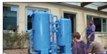
Abb. 5: Die Absorptionskälteanlage wird angeliefert
