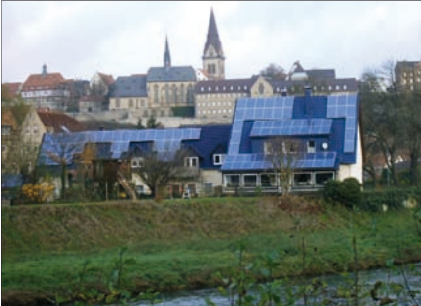
Photovoltaikanlage auf einem farbig beschichteten Dach
