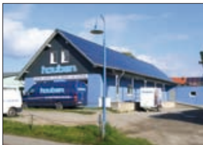
Bild 10: Dachanlage mit CdTe-Modulen
