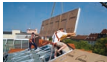
Abb. 4: Montage der Flachkollektoren
