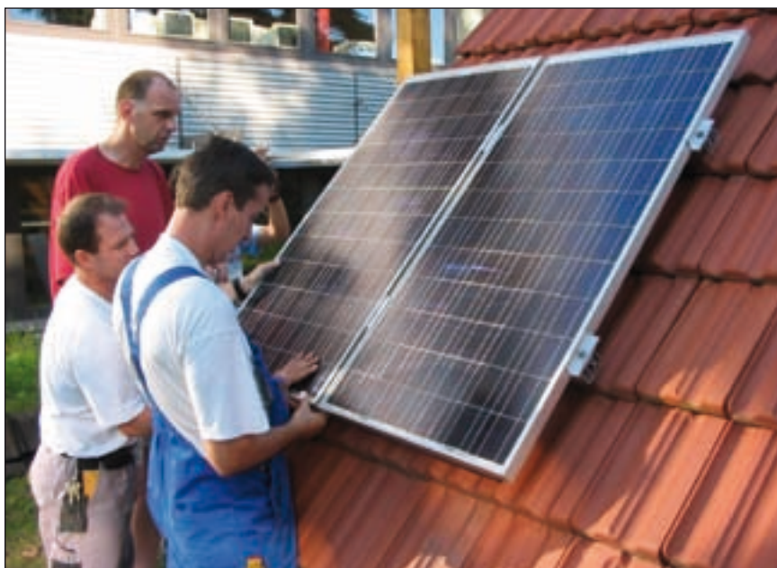
Bild 2: Einhängen der Module (Foto aus früherem Kurs)
