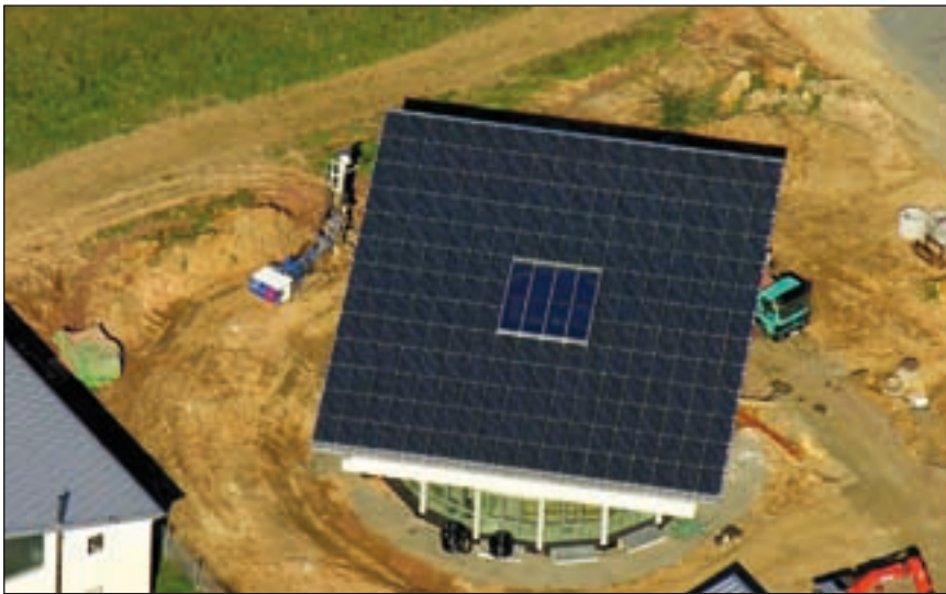
Bild 1: Ansicht des Daches von oben
