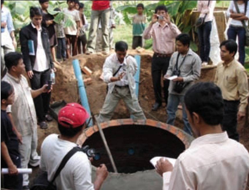
Bild 1: Kleinbiogasanlage im Bau, Kambodscha
