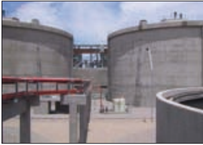
Bild 5: Klärschlammvergärung in El Trebal, Aguas Andinas
