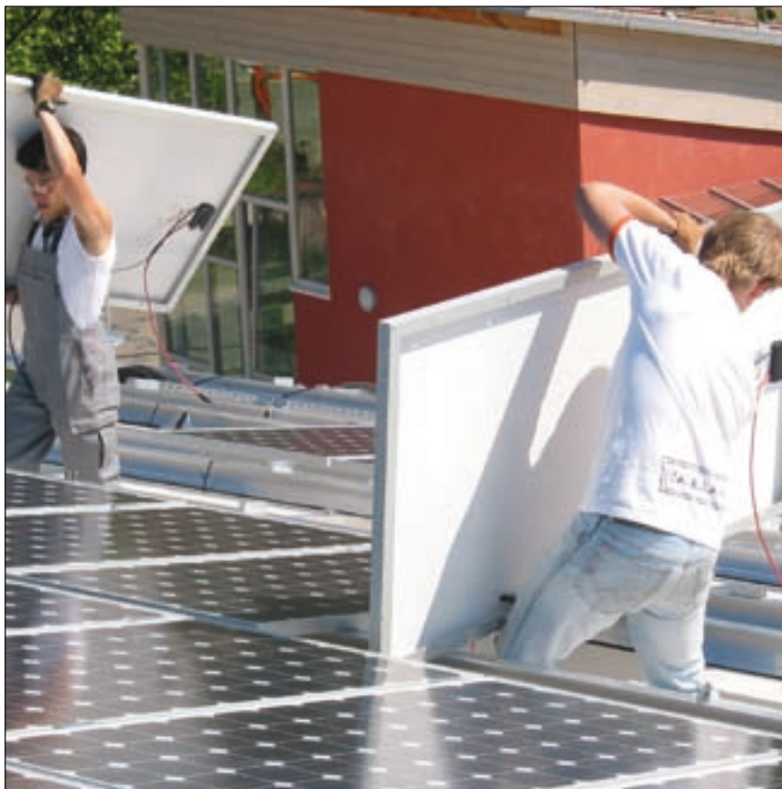
Bau einer Solarstromanlage
