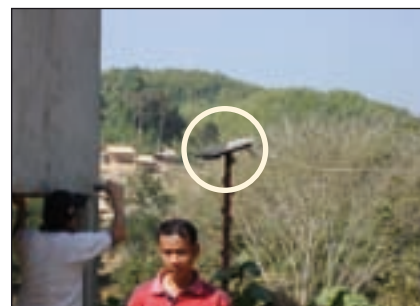
Bild 8: Verschattetes Modul für Stromversorgung der Nachführung
