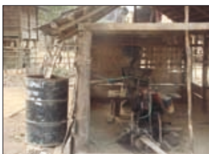
Bild 4: Dieselgenerator für den Betrieb einer Reismühle
