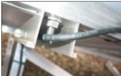
**Bild 4:** Diese Kabelverlegung gehört als Mangel in das Abnahmeprotokoll: An den scharfen Kanten der Unterkonstruktion können die Leitungen scheuern und im schlimmsten Fall einen Kurzschluss verursachen.
