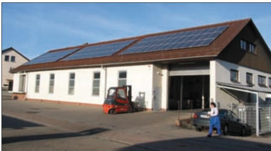
**Bild 5:** Eine Solarstrom-Gemeinschaftsanlage kurz nach Fertigstellung. Sichtbar auch die Einbeziehung der Anlage in den Blitzschutz des Gebäudes durch Fangstangen im First- und Traufbereich.
