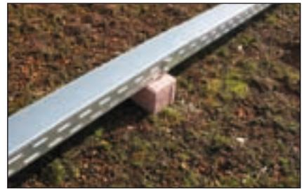
Bild 3: Die Stromkabel dieser Großanlage auf einem begrünten Flachdach wurden in einem geschlossenen Kabelkanal verlegt.
