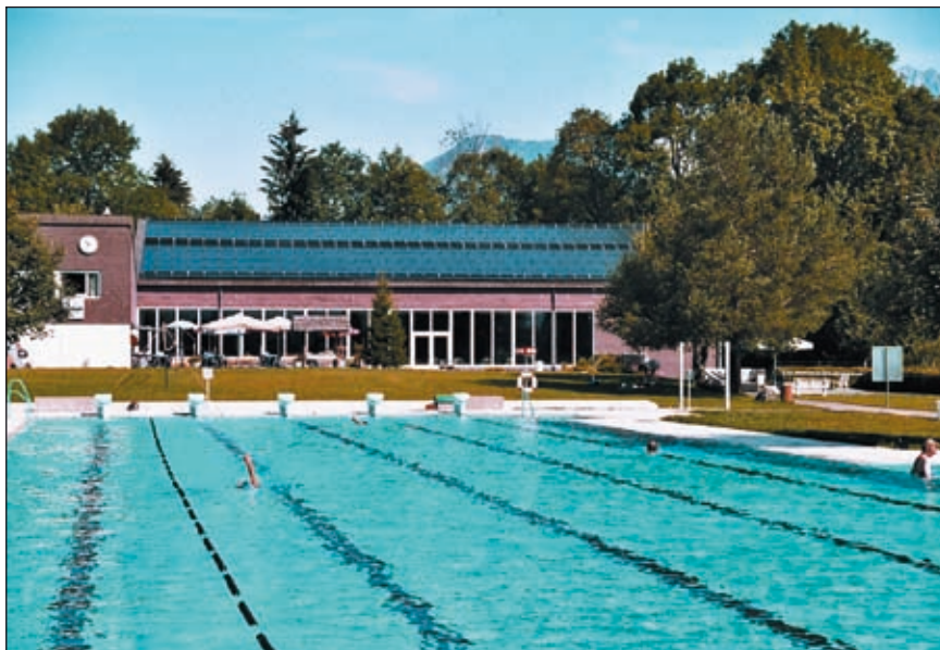
Bild 1: Freibad mit Absorberanlage
