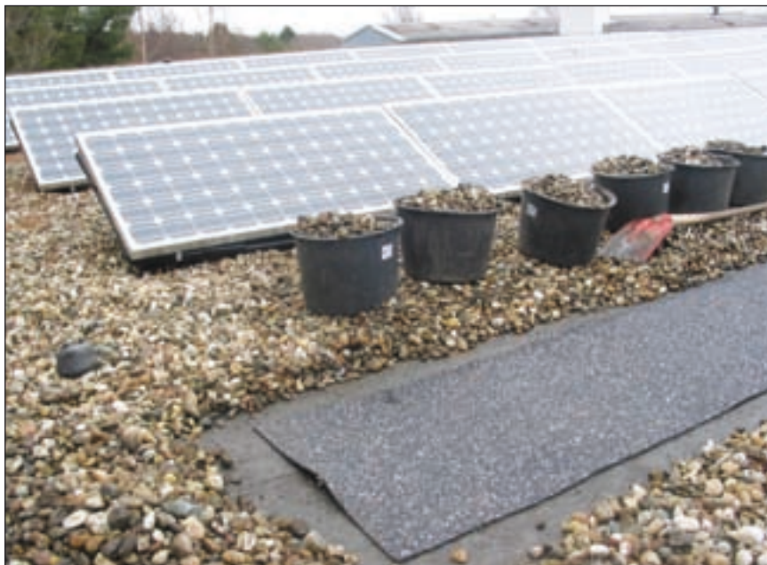
Bild 2: Fotos dokumentieren den Anlagenbau
