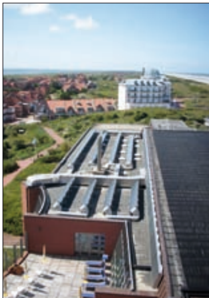
Bild 1: Hallenbad Juist – Absorber-Luftkollektor-Wärmepumpen-Kombination
