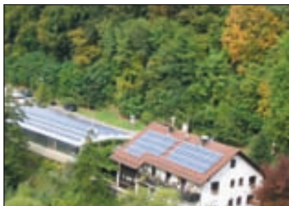
Bild 1: PV-Anlage eines kleinen Gewerbebetriebes
