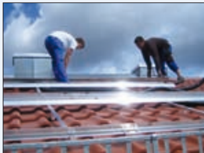
Aufdachmontage (Rudolphstraße, Nürnberg)
