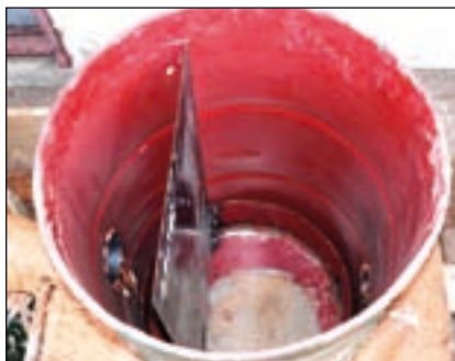
Bild 7: Blick in den im Bau befindlichen Ascheabscheider
