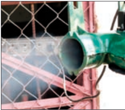
Bild 10: Wasserdampffahne am Gebläseaustritt
