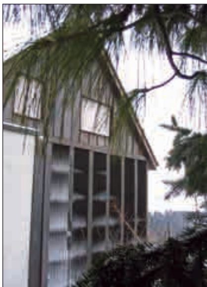
Bild 4: Thermisch aktivierte Metall-Fassade (Beck)
