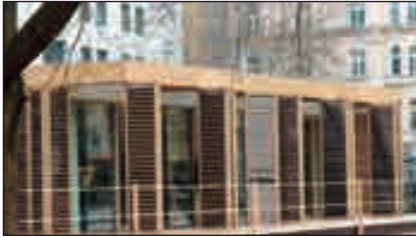
Das Plusenergiehaus auf dem Münchner Marienplatz hat Drei- und Vierfachverglasungen bis zum U-Wert 0,35 W/m 2 K!
