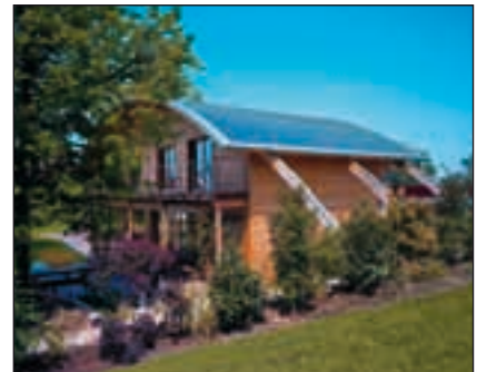
Bild 15: Gerundetes PV-Dach, RZ
