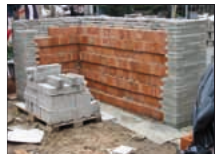
Bild 2: Die Innenwände bestehen aus Ziegelmauerwerk, ebenso der Kern der Außenwände.
