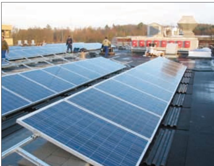
Montagearbeiten bei einer großen PV-Anlage
