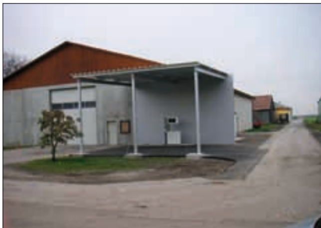
Biogastankstelle in Österreich
