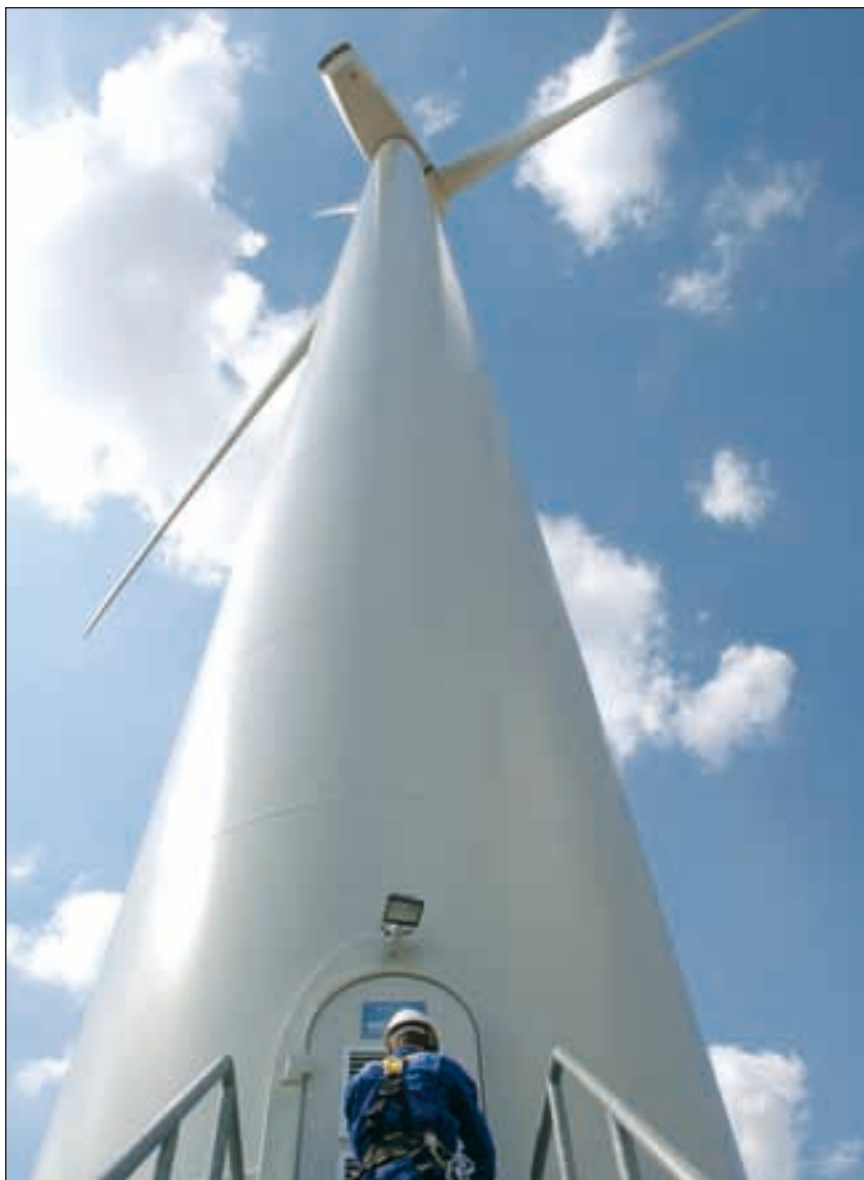
Über zwei Millionen Haushalte wollten im vergangenen Jahr Strom von Windenergieanlagen, Photovoltaiksystemen und Biomassekraftwerken.
