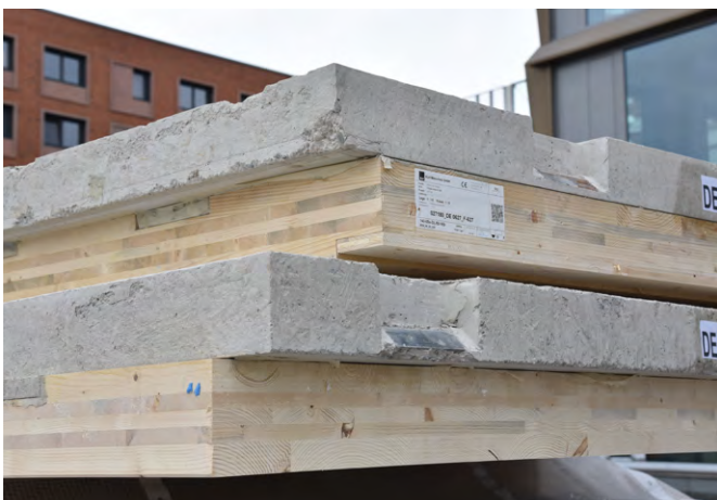
Deckenaufbau Die Geschossdecken bestehen aus Holz-Betonverbundelementen, in der Untersicht aus Brettspertholz, in der Obersicht aus Beton
