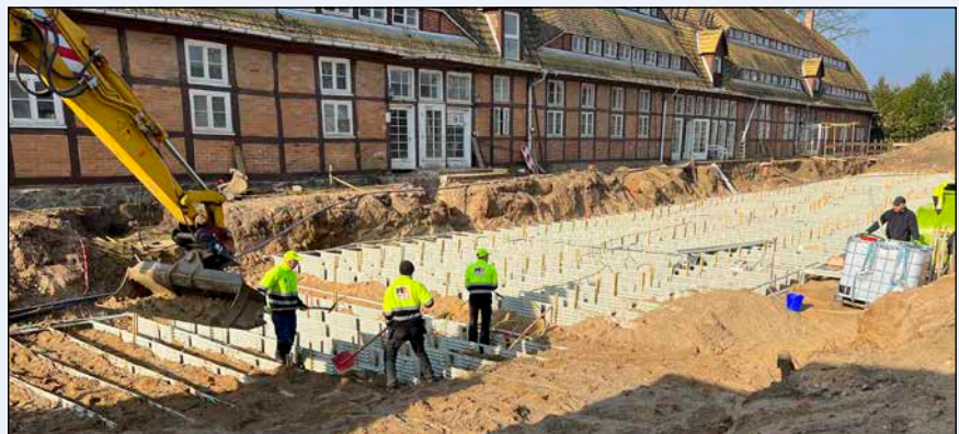
Bild 2: Für die zukunftssichere Wärmeversorgung der 200 Jahre alten Klosteramtsscheune in Dobbertin kommen 1.800 Kollektoren zum Einsatz. Verlegt werden sie auf zwei Ebenen übereinander. Später wird der Bereich als Terrasse genutzt.
