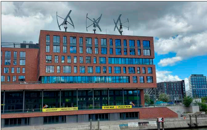
Bild 3: Kleinwindanlagen auf einem Bürohaus-Flachdach in der Hamburger Hafencity. Nur vorne, wo die „Windwelle“ hoch strömt, gibt es genügend Windgeschwindigkeit. Die Windströmung ist allerdings nicht so gut für HAWT-Anlagen geeignet
