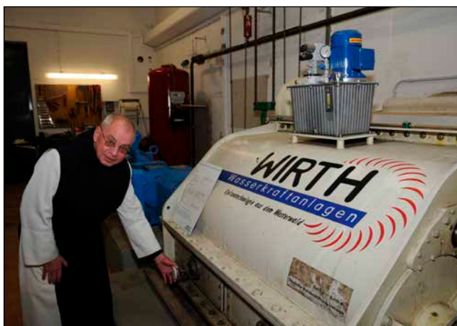
Bild 3: Eine Banki-Durchströmturbine mit einer Leistung von 95 kW unterstützt die Versorgung der Abtei Marienstatt im Westerwald. Im Bild zu sehen ist Abt Dr. Thomas Denter.
