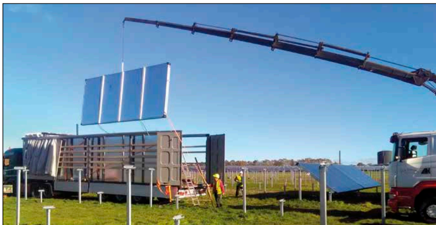
Bild 2: 16 m 2 große freitragende Kollektoren brauchen wenig Stützen
