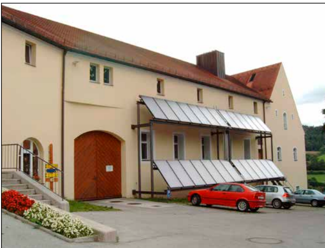
Bild 6: Die Abtei Plankstetten erzeugt Biogas, nutzt Holzhackschnitzel und mehrere Solaranlagen. Zu sehen sind die aufgeständerten Solarkollektoren an der Fassade eines Wirtschaftsgebäudes.
