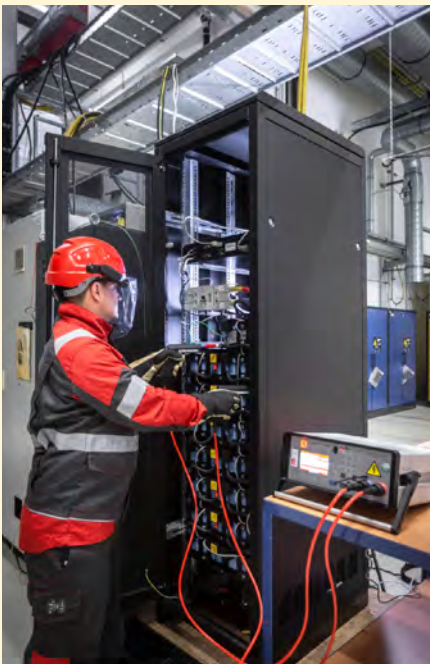
Labor Auch Batterien müssen getestet werden, wie hier ein Hochvoltssystem am Fraunhofer-Institut für Solare Energiesysteme ISE
