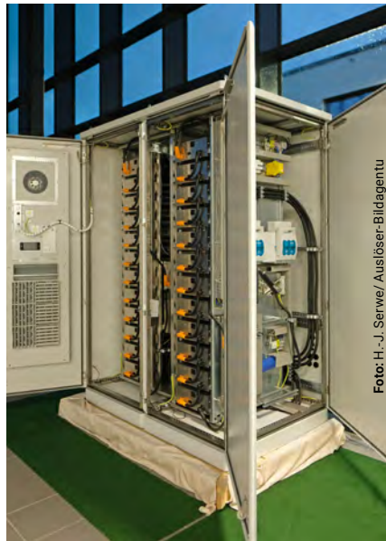
Showroom Das Unternehmen Voltfang GmbH konzipiert Second-Life-Stromspeicher für Industrie und Gewerbe. Hier ist der Voltfang2-Stromspeicher mit einer Kapazität von 180 KWh zu sehen
