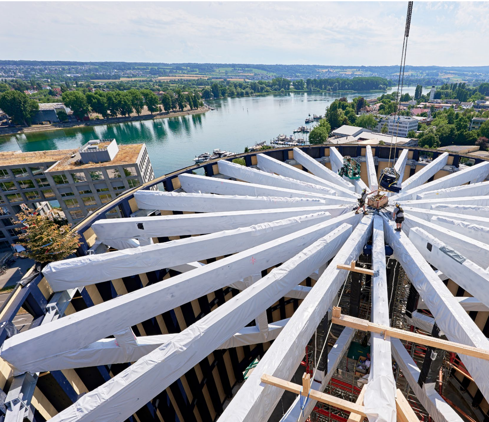
Holzkonstruktion Das Gebäude am Konstanzer Seerhein wirkt wie ein eigenständiges Kunstwerk und wird ein neues 360°-Panorama-Bild von Yadegar Asisi beherbergen
