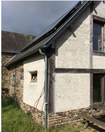
Normandie Fachwerkhaus mit Hanfkalk zwischen den Hölzern
