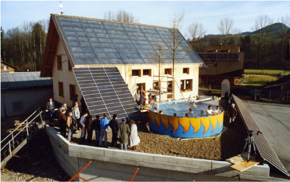
Schweiz Das Sonnenhaus in Oberburg speichert so viel solare Wärme, dass diese noch im Januar einen Swimmingpool heizen kann.
