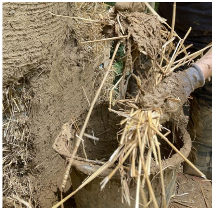
Handeln Stroh gemischt mit Lehm für Lehmputz
