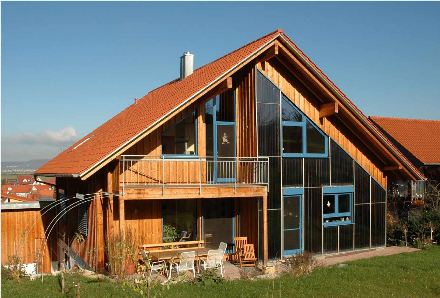
Niedrigenergiehaus Bei senkrechter Bauweise der Fassadenkollektoren kann die Wintersonne mit größerem Wirkungsgrad genutzt werden als bei einer Installation auf der Dachfläche
