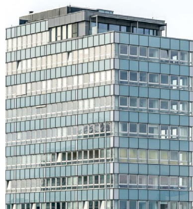
Büroebau Das Hochhaus »Matchbox« in Eschborn ist ein schönes Beispiel für bauwerkintegrierte Photovoltaik (BIPV)
