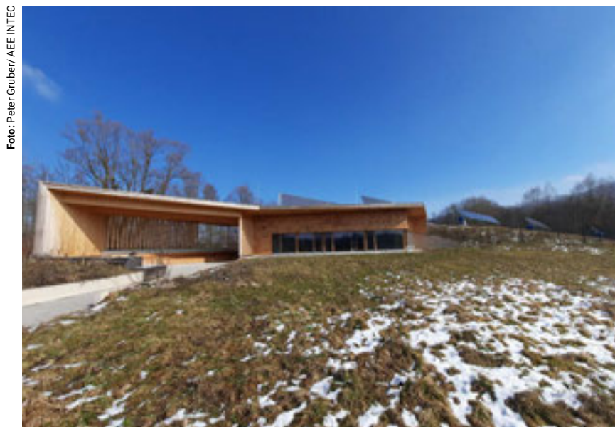
In den Salzachauen Autark versorgtes Ausbildungsgebäude: Kernstück für die Wärmespeicherung und -verteilung sind die Beton-Bodenplatte sowie die Vollholzdecke – beide thermisch aktiviert
