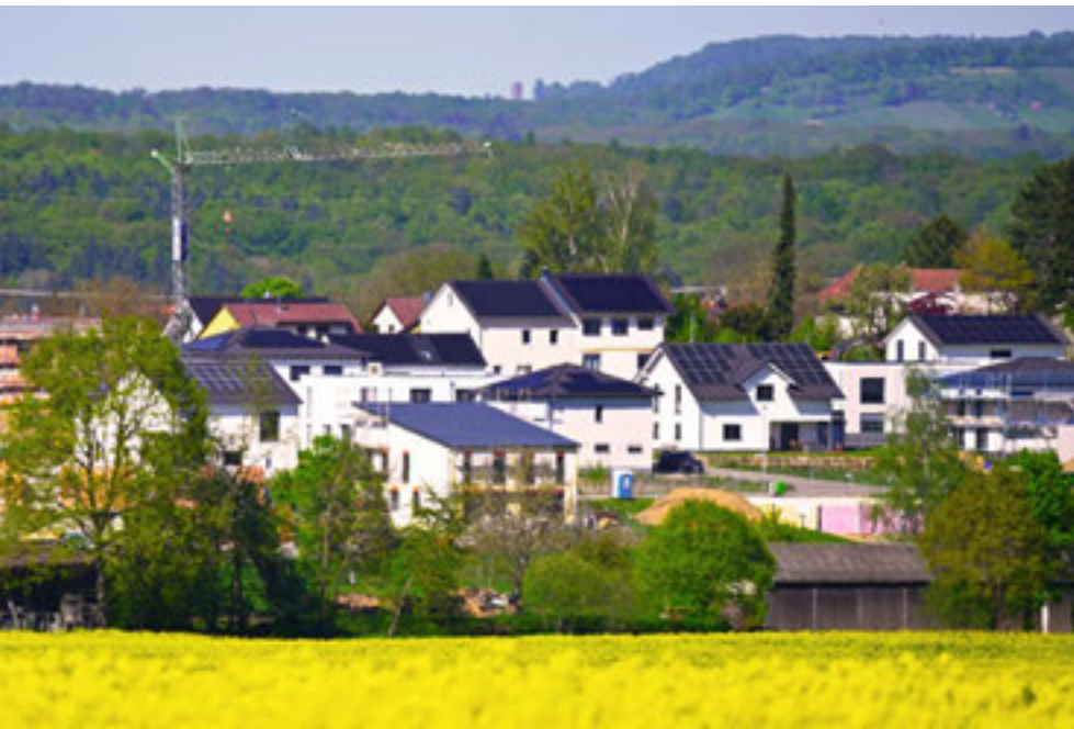
Solarwende PV-Anlagen in Baden-Württemberg hinter einem Rapsfeld. Hier gilt eine Solarpflicht für Neubauten, daher sind hier so viele Gebäude mit Solarmodulen bestückt
