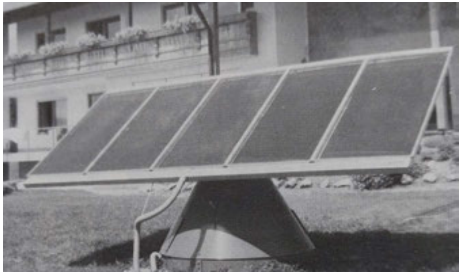
Mobile Kollektoranlage Die Nachführanlage soll leistungsmäßig ein Drittel weniger Kollektorfläche benötigen als fest eingebaute Kollektoren (Heft 2/1984)
